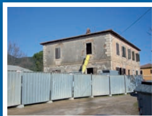
Prima della ristrutturazione
